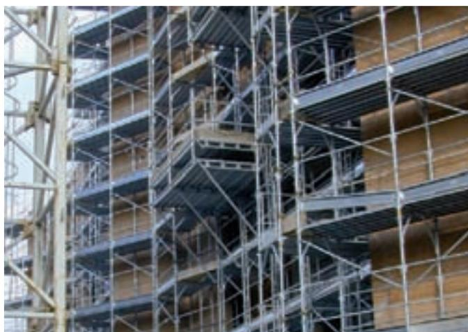
I piani di carico a sbalzo, utilizzati in abbinamento anche con i telai prefabbricati, arrivano a portate di 450 kg/mq. Possono essere semplici (180 cm x 180/250 cm) o composti (180 cm x 360/500 cm), per facilitare lo sfilamento della forza dai bancali portati in quota.
