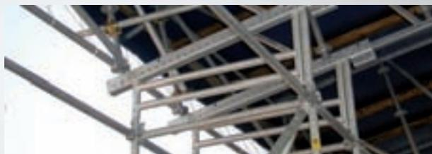
Per il loro posizionamento vengono utilizzati elementi di appoggio piani o inclinati a 12,5° per le coperture.
