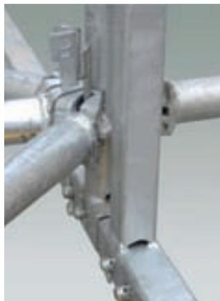
Ogni trave viene collegata all'altra con i normali correnti e diagonali del sistema Multiceta® o in casi particolari con tubo e giunto (vedi foto: particolare della giunzione tra travi con spinotto, perno, copiglia e nodo Multiceta®).
