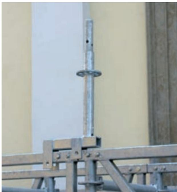
Sopra le travi si può installare il ponteggio grazie agli elementi di ripartenza che vengono fissati con semplici perni, la distanza tra la rosetta dell'elemento di ripartenza è posizionata ad una distanza tale da mantenere sempre i 50 cm da quella inferiore. (vedi foto).
